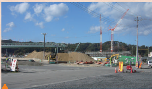
山田町のかさ上げ工事。山を削って高台にし、土砂をベルトコンベヤで運搬して地盤に盛る。
