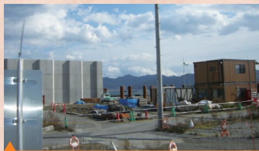
海を隔てる防潮堤の整備。併せて避難対策も強化していく。
